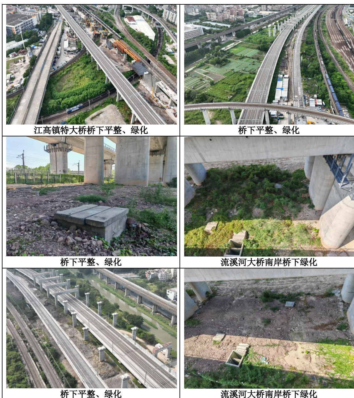
图 6.3-2 桥梁防护工程现状照片
