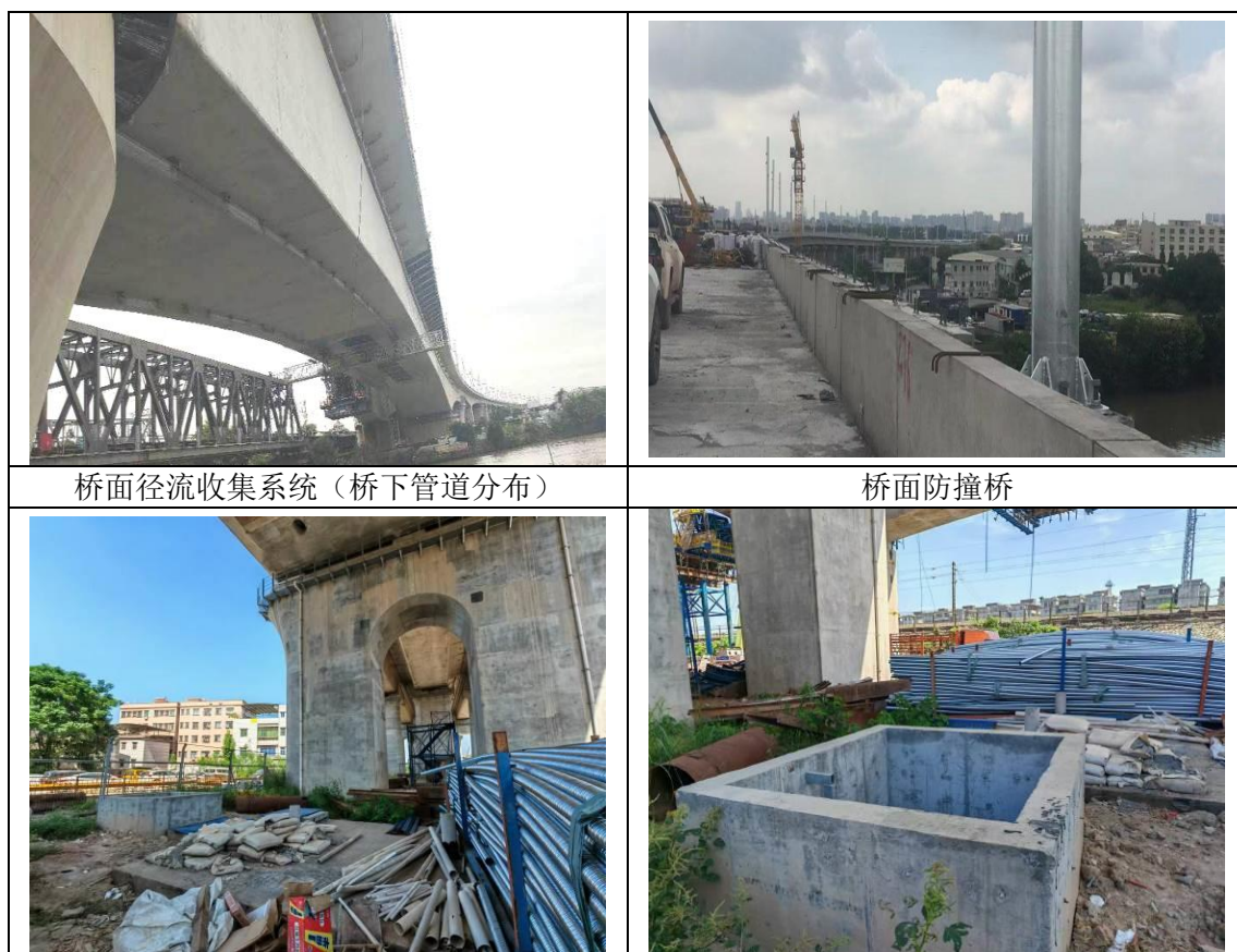
图 9.2-5 水源保护区内施工期相关保护措施
