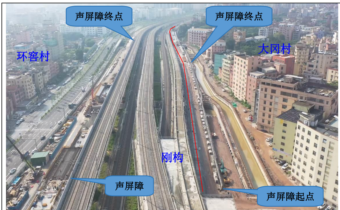
大冈村声屏障航拍照片
