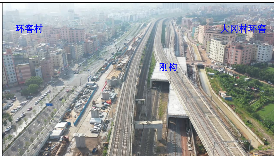
大冈村声屏障航拍照片
