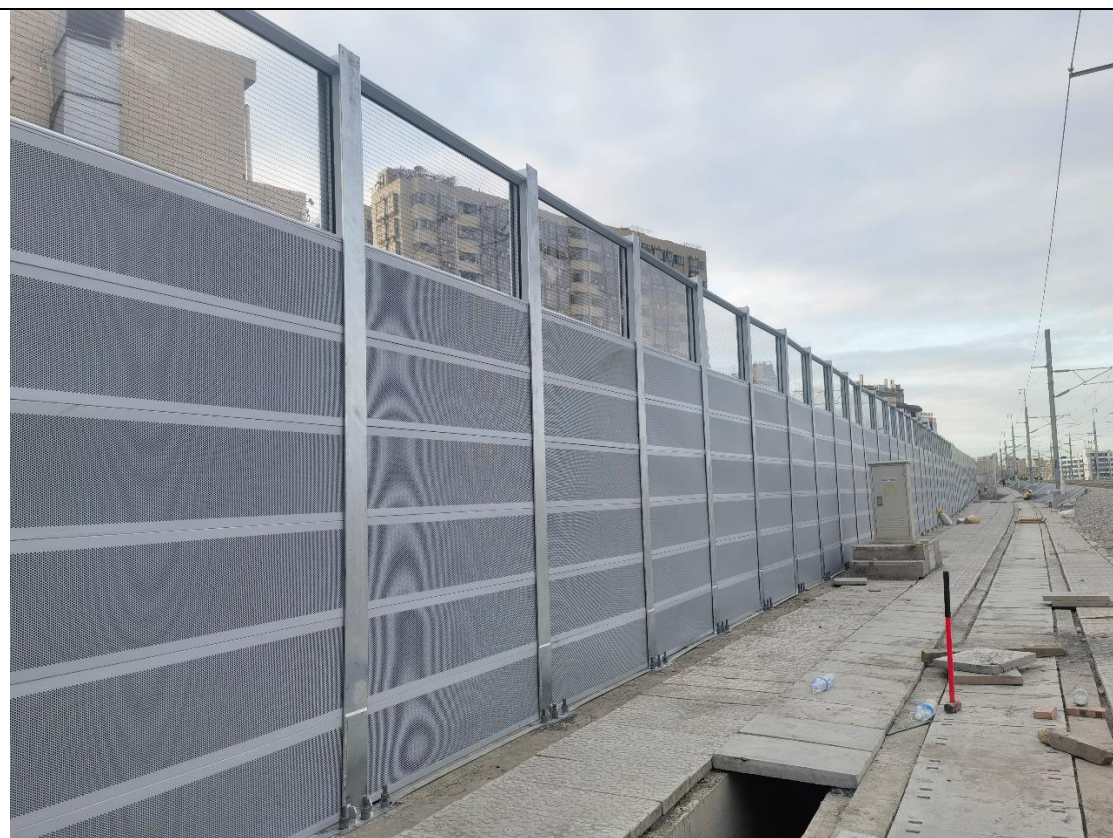
榕溪村声屏障现状照片
