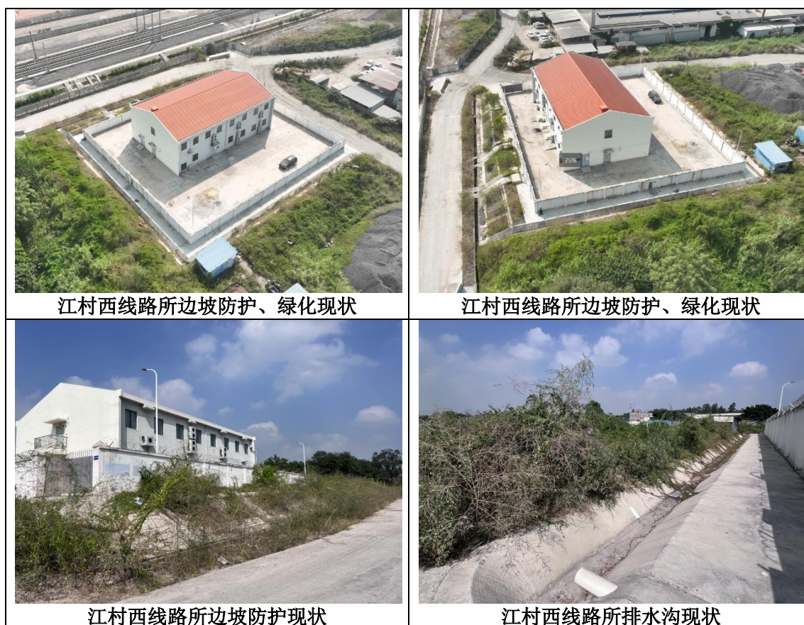
图 6.3-4 站场防护工程现状照片
