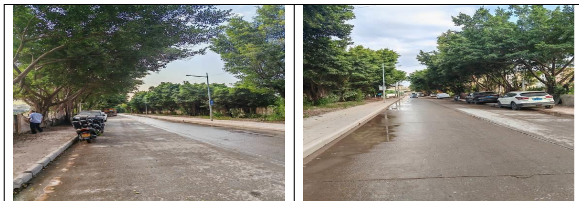
图 6.3-8 本工程施工便道现状照片
