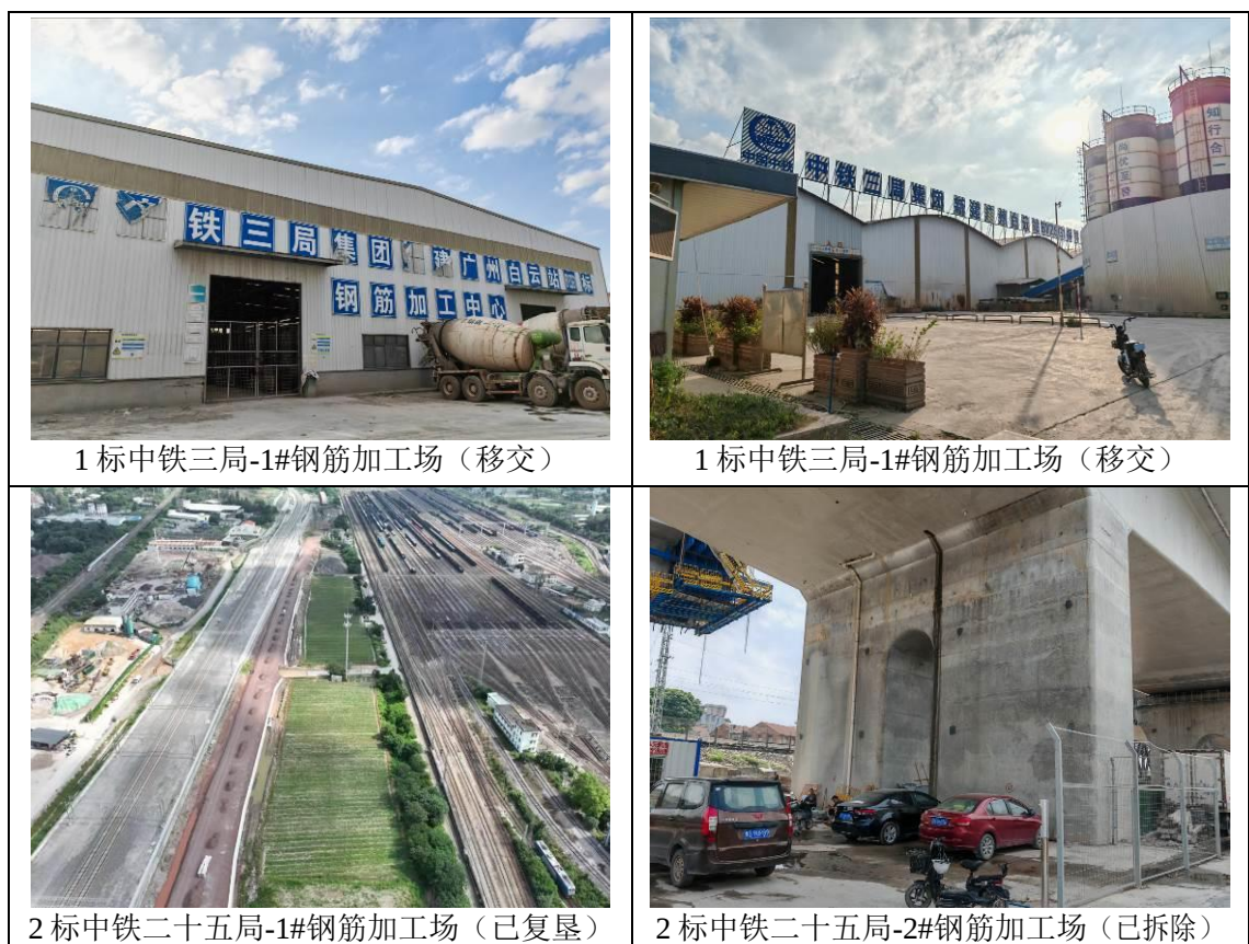
图 6.3-7 本工程钢筋加工厂现状照片
