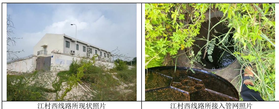
图 9.3-1 江村西线路所现状及污水处理设施
