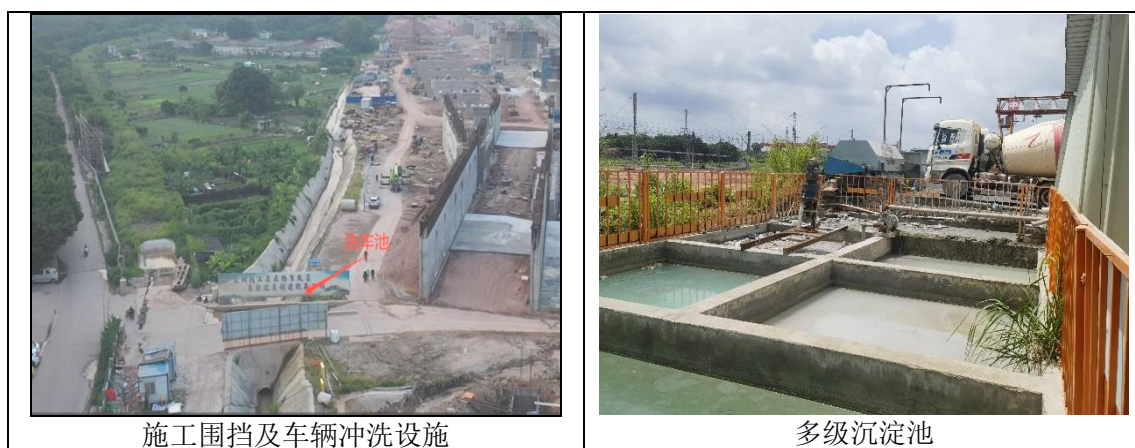
图 5.10-1 施工期措施落实情况照片
