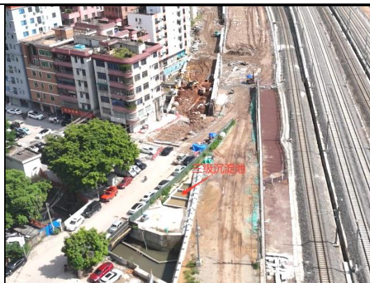
施工围挡及沉淀池
