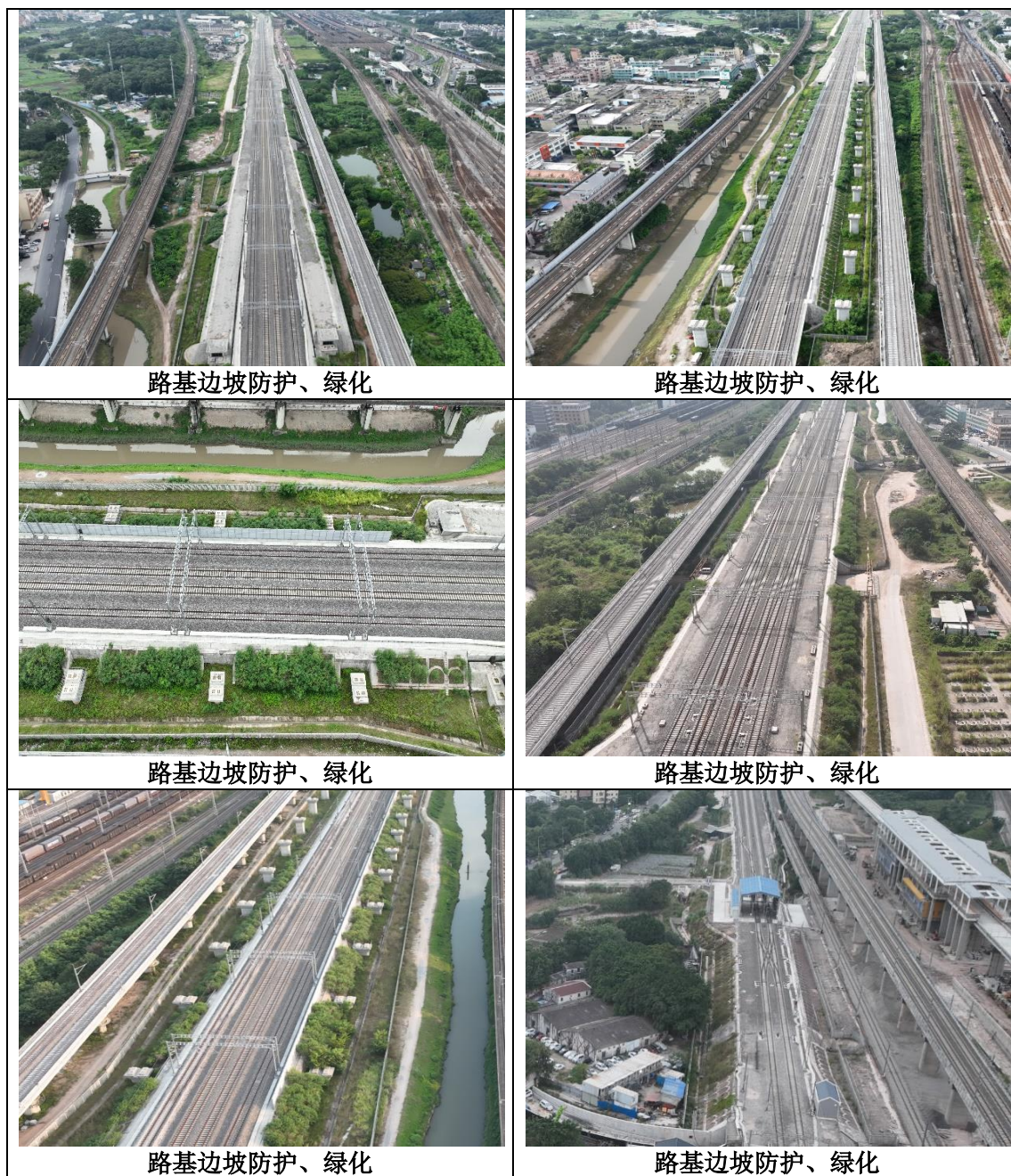
图 6.3-3 路基防护工程现状照片
