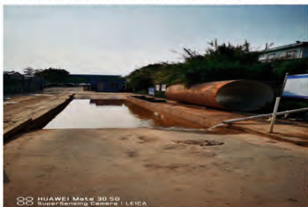
肇庆东施工营地洗车池
