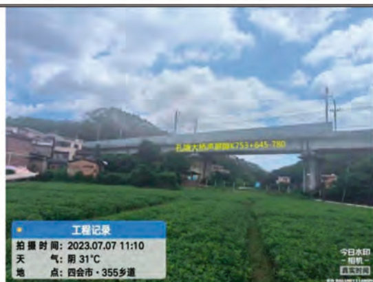
孔塘大桥声屏障病害整治
