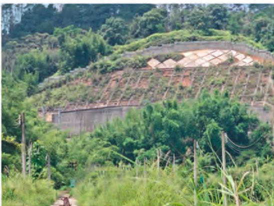
K758+101 坡面风化边坡防护
