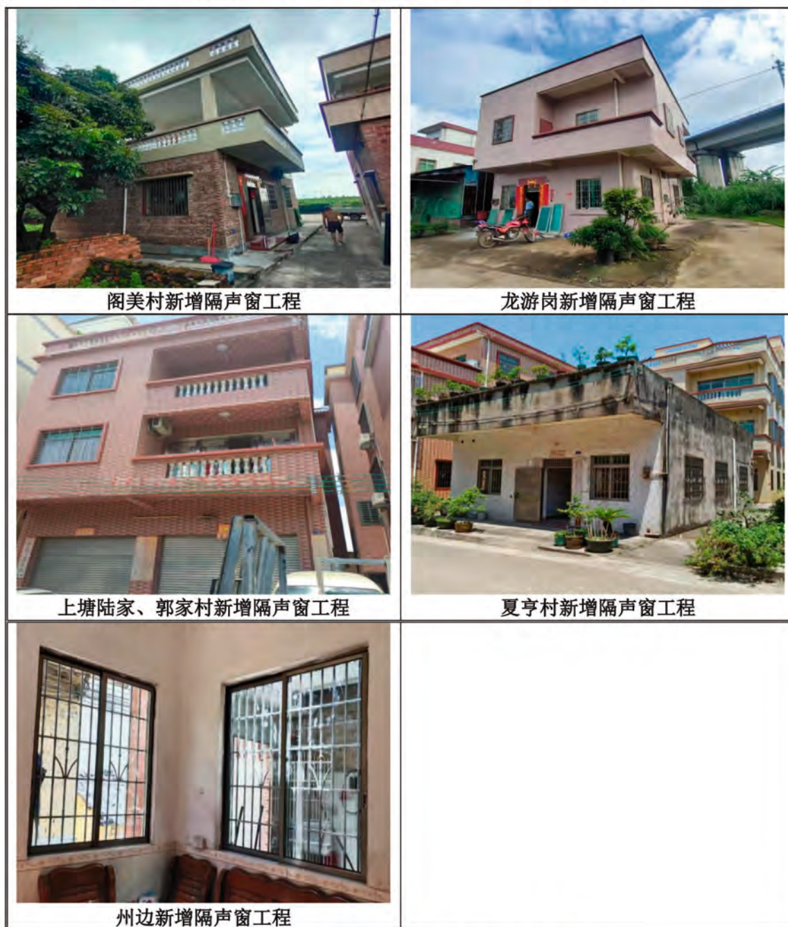
图 7.2-2 现场调查的隔声窗安装照片
