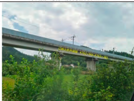
辽畔特大桥声屏障病害整治
