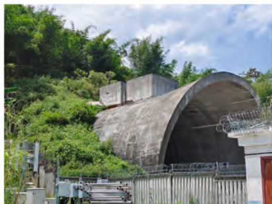
K735+680 下行侧路堑边坡防护
