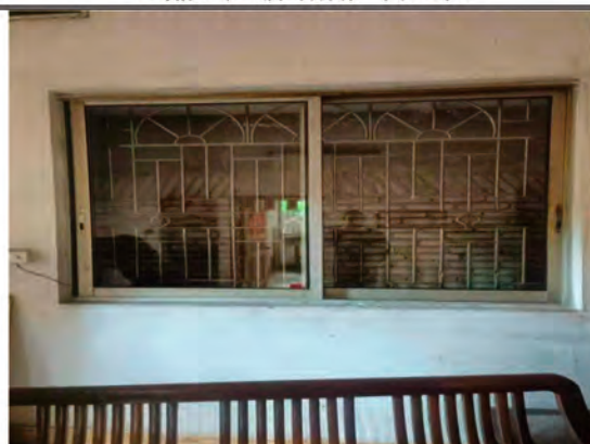
坡塘寨新增隔声窗工程
