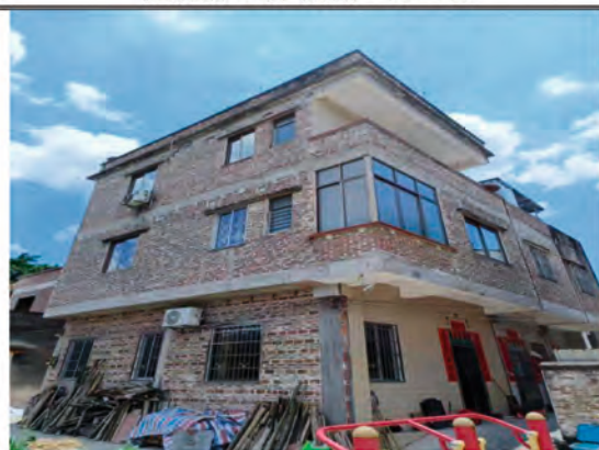
巷口新增隔声窗工程
