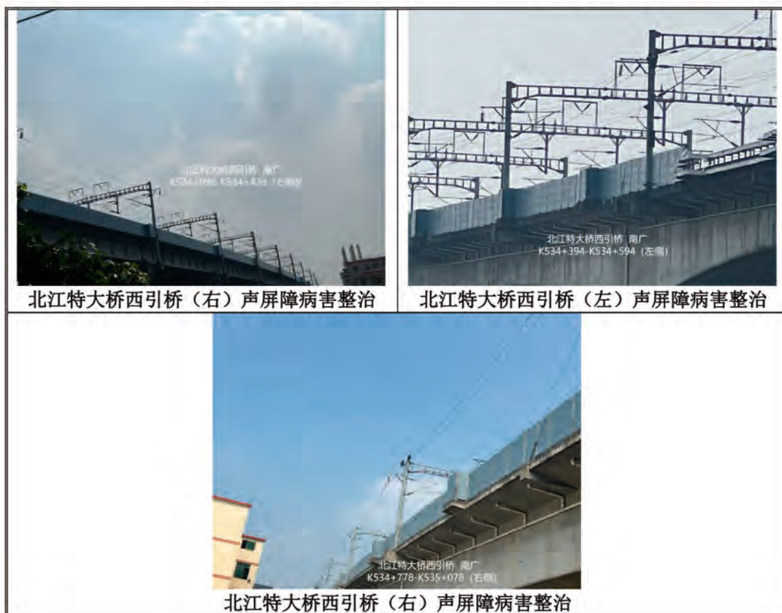
图 7.2-1 沿线声屏障病害整治现场调查照片
