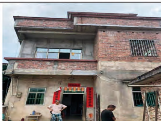
坑口新增隔声窗工程
