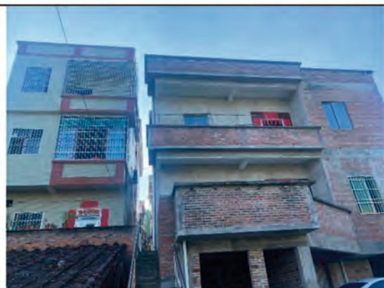
新铺新增隔声窗工程
