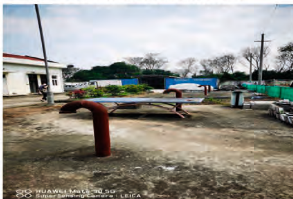
肇庆东施工营地、房建工程生活污水化粪池
