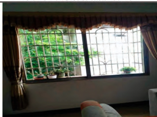
石仔岗新增隔声窗工程
