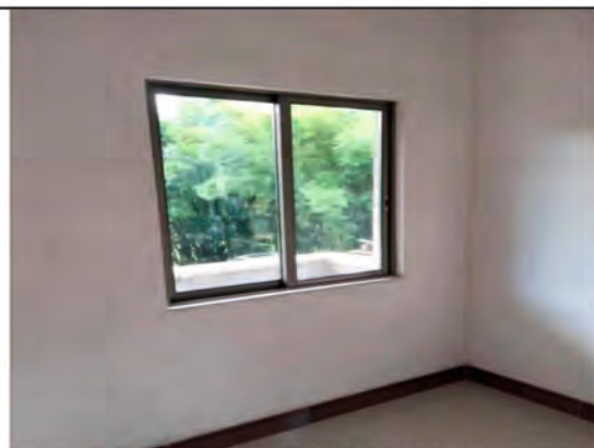
增洞坑口新增隔声窗工程
