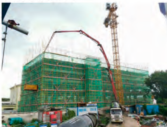
肇庆东站 新建宿舍楼
