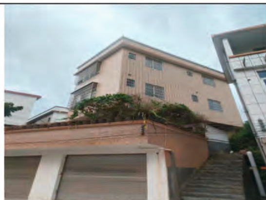
车轮坪、大坡村新增隔声窗工程
