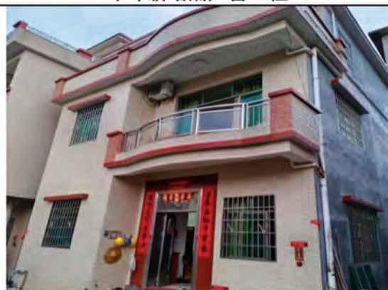
大岗社、大布岗新增隔声窗工程
