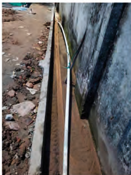
肇庆东施工营地排水沟
