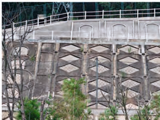
K728+836 雅平顶隧道出口左路堑边坡溜坍防护
