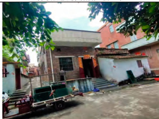
区家村、陆家村新增隔声窗工程
