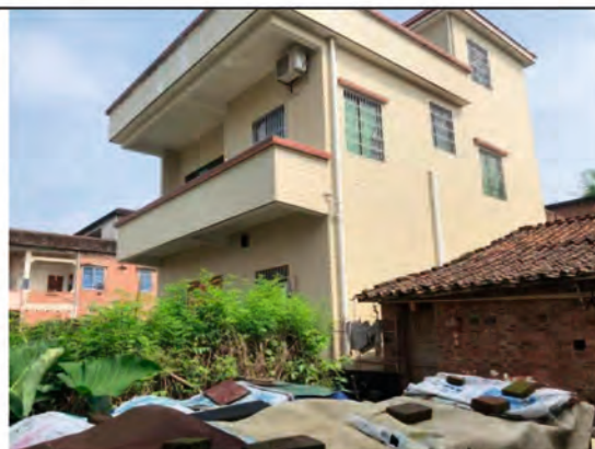
小水村新增隔声窗工程
