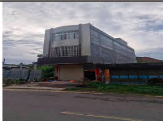
梅坑新增隔声窗工程
