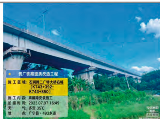
石洞跨二广高速特大桥（右）声屏障病害整治
