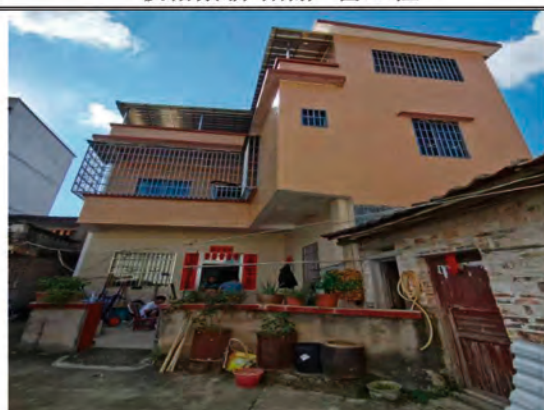
屈山村新增隔声窗工程
